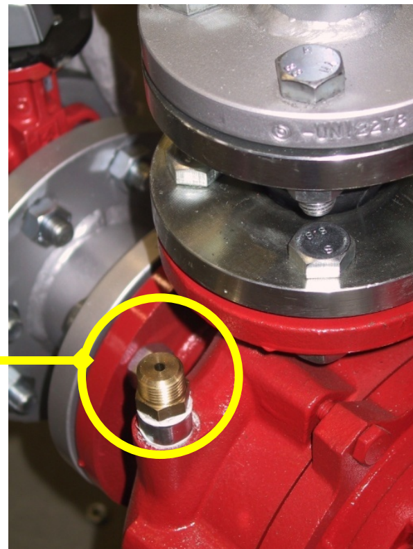
Diametro orifizio da 4 a 10 mm in funzione della portata minima termica della pompa (2% della portata limite)
